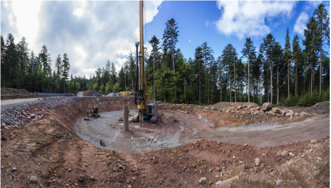
Dauerhafte Waldzerstörung durch Errichtung von Windindustrieanlagen (Foto: Joachim Wasserthal)
